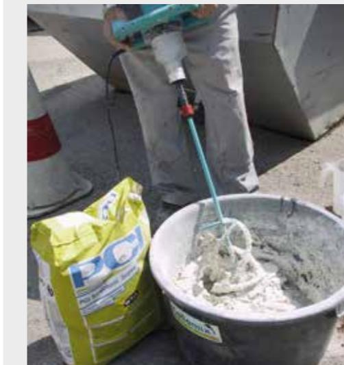
Рис. 7 – Мешалка типа MK для растворной смеси.
