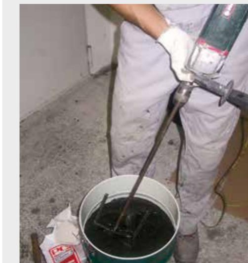
Рис. 9 – Смеситель параллельного типа для смещивания PCI Pecimor® 2K.
