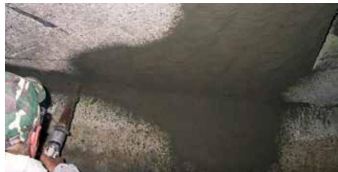
Рис. 18 – Нанесение ремонтной смеси с помощью растворонасоса.
