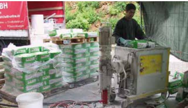
Рис. 17 – Закрытая система – Смесительный насос M-TEC Duomix 2000.
