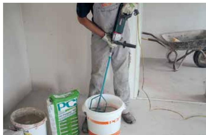
Рис. 2 – Применение смесителя параллельного типа.
