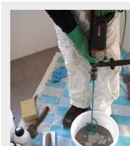
Рис. 5 – Низкооборотистый смеситель со спиральной насадкой WK 70 или MM для небольших объемов смеси.
