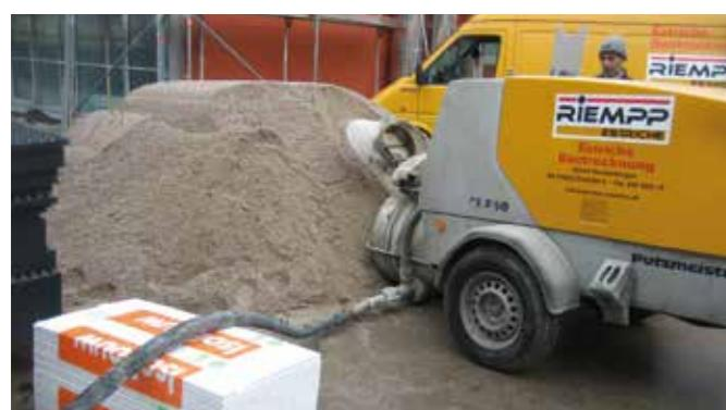
Рис. 21 – Насос для стяжки: рукав поднят для облегчения прокачки готовой смеси.
