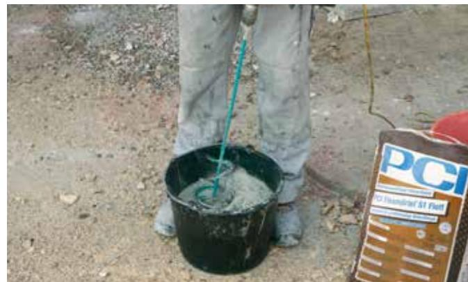
Рис. 1 – Применение низкооборотистого смесителя со спиральной насадкой.
